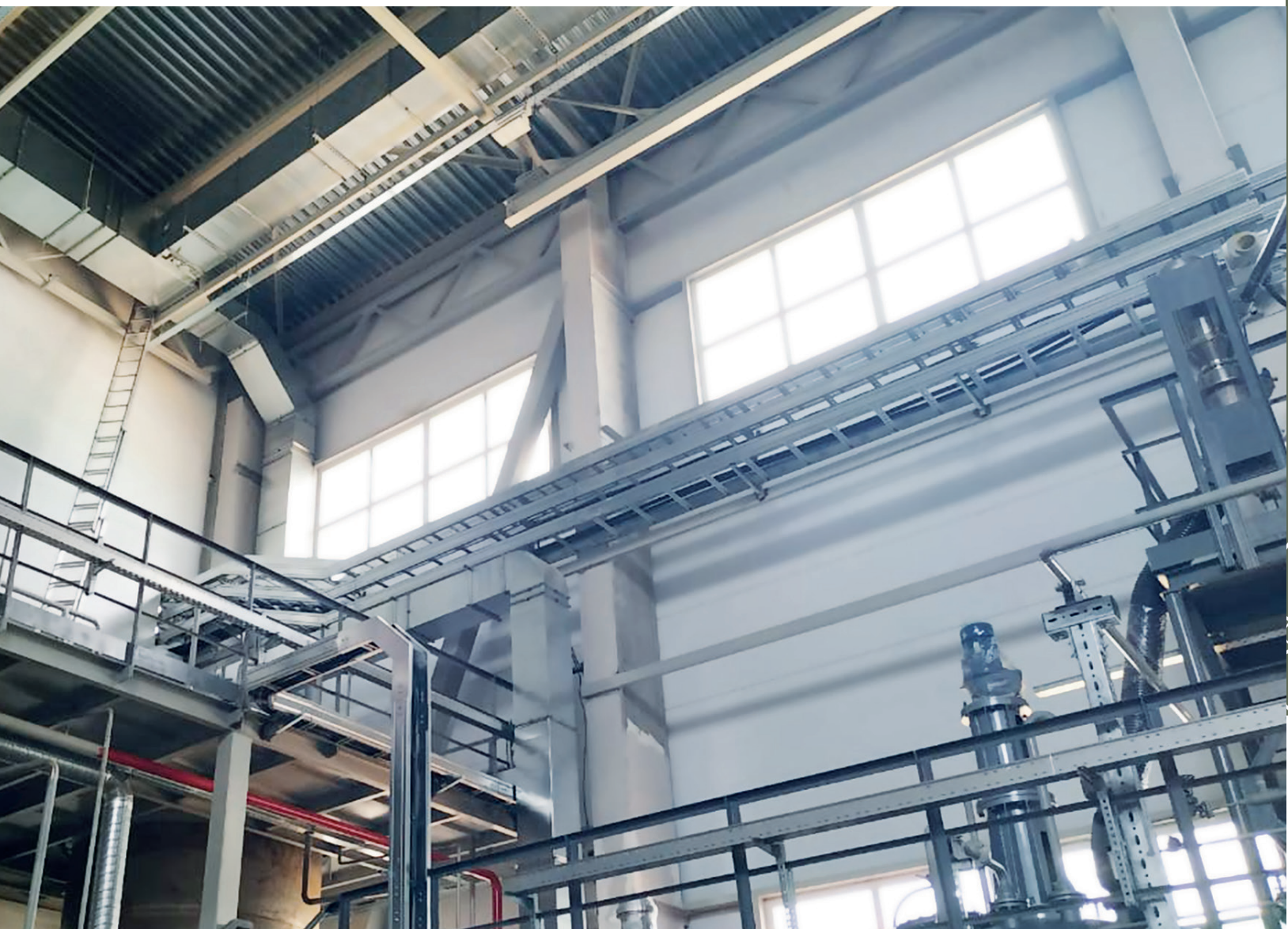
Наши объекты: Завод по производству средств защиты растений, Липецкая область.
