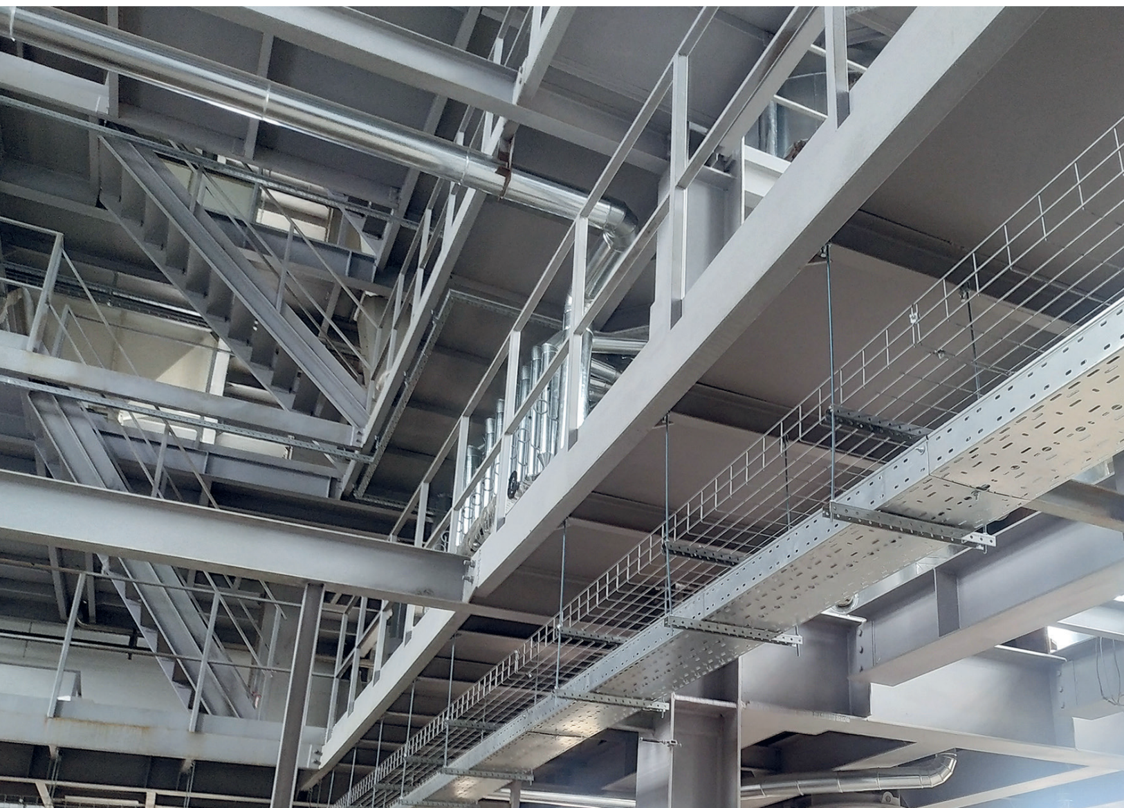
Наши объекты: Маслоэкстракционный завод, Воронежская область.
